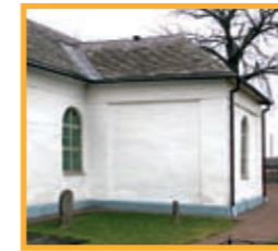
Sakristian på kyrkans sydsida byggdes under perioden 1650 - 1680 som ett gravkor i två våningar. Det nedre planet användes som gravkor och den övre delen gjordes till en herrskapsläktare med valv ut mot kyrkorummet.
